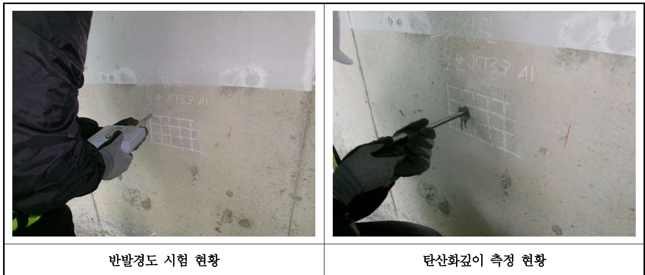
【사진 33.4.1】 콘크리트 내구성조사 현황
