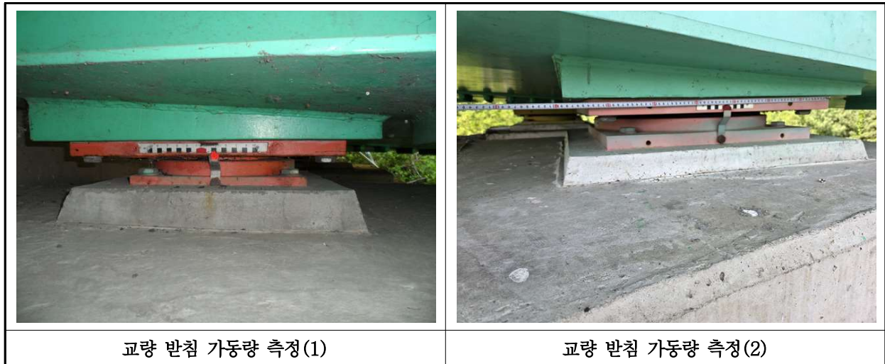
【사진 33.3.16】 교량받침 이동량 측정
