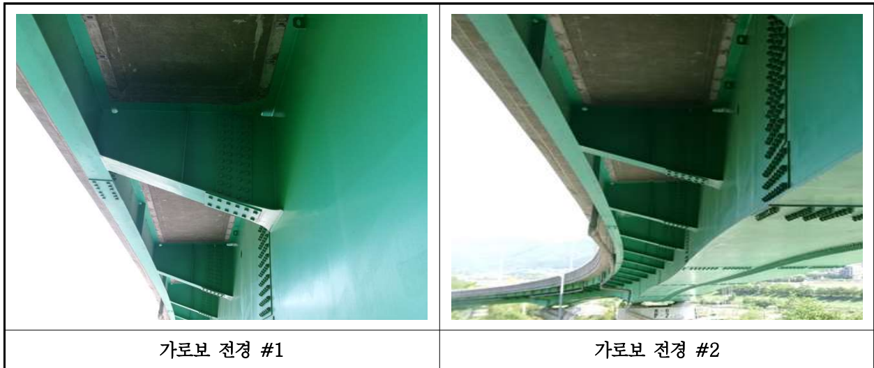
【사진 33.3.6】 가로보 전경
