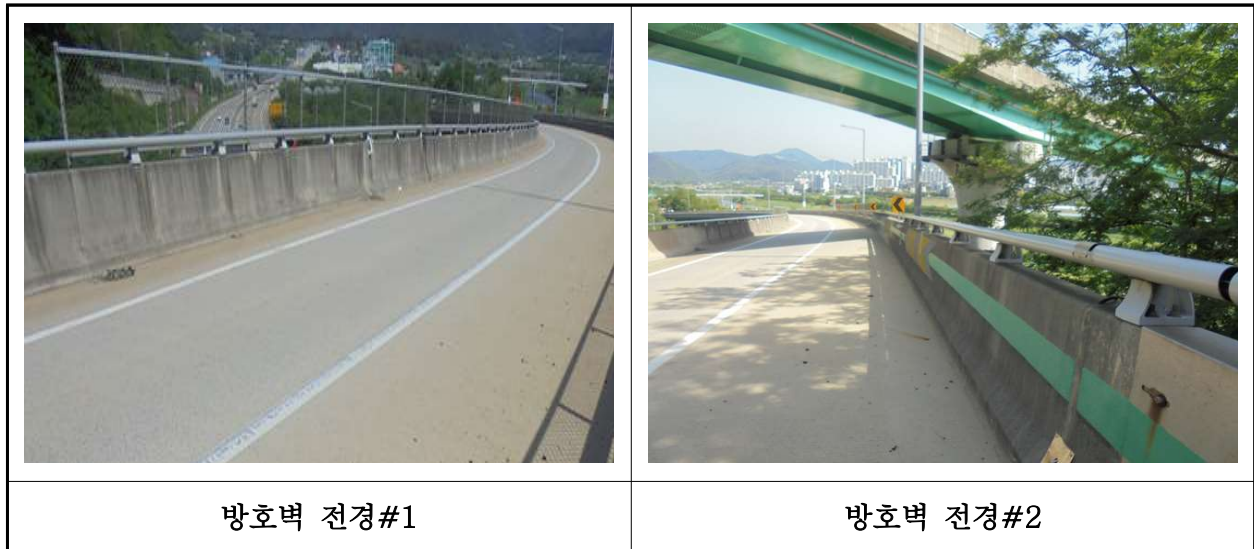
【사진 33.3.24】 방호벽 및 중분대 전경
