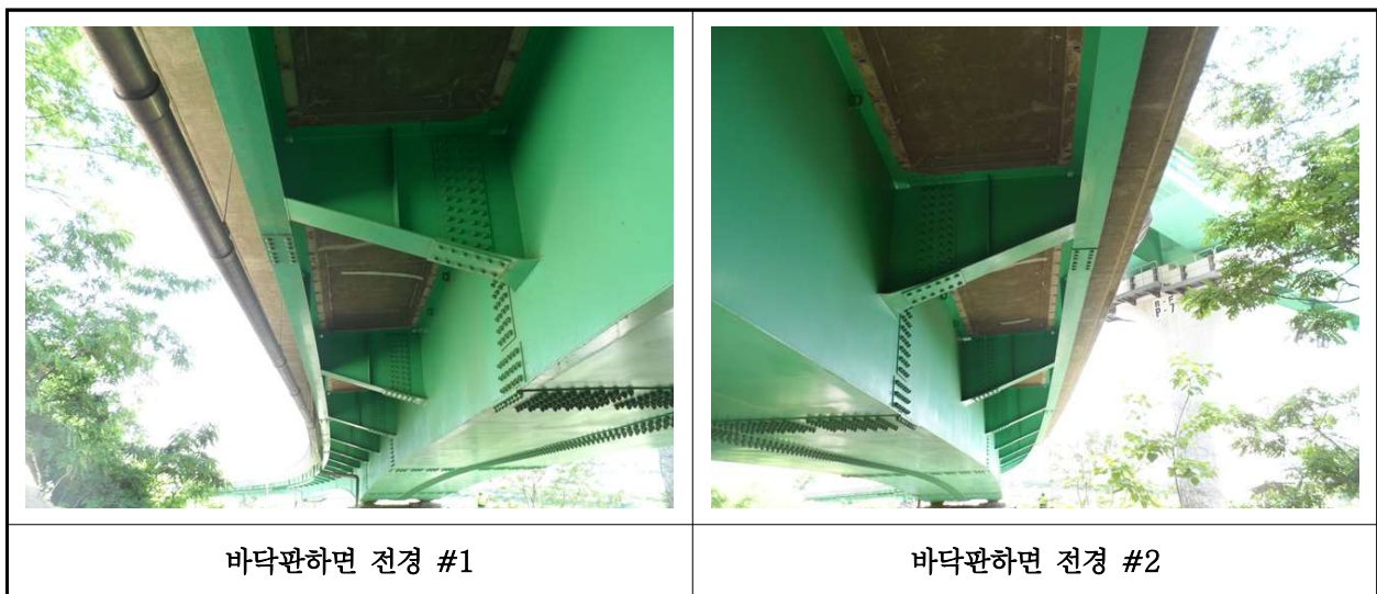
【사진 33.3.2】 바닥판하면 전경
