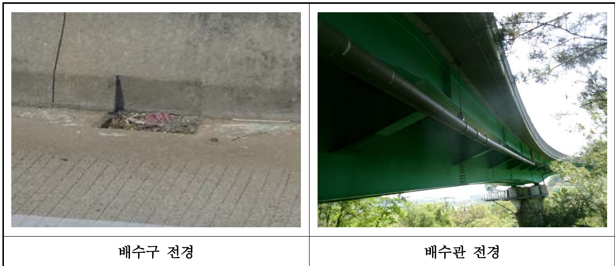
【사진 33.3.22】 배수시설 전경
